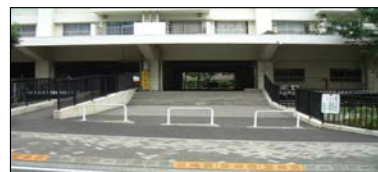
②都営南砂1丁目住宅
