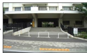
②都営南砂1丁目住宅
